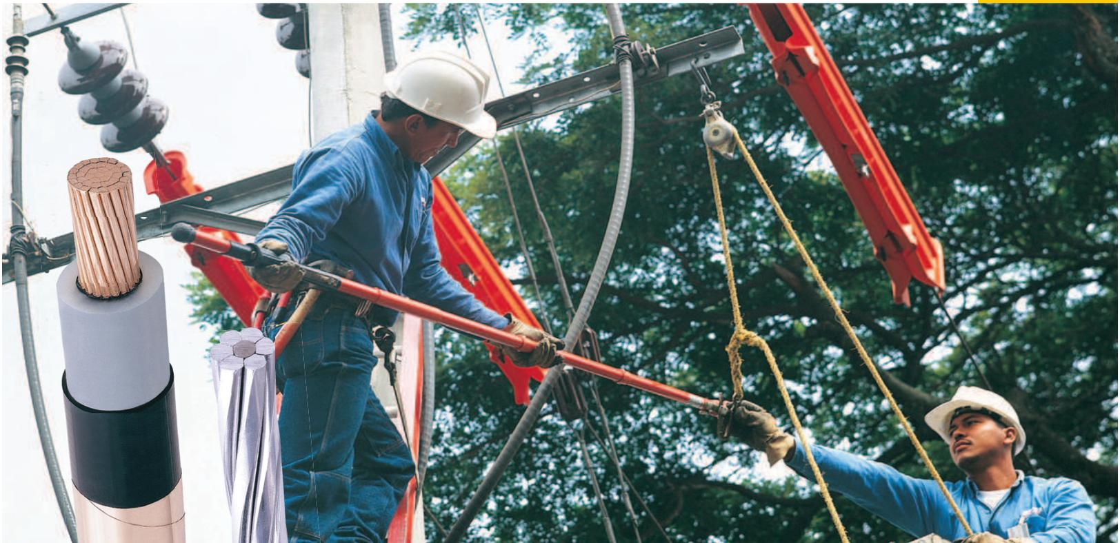
*Los Cables para Media Tensión con aislamiento en triple extrusión y curado en seco fabricados por CENTELSA son utilizados en sistemas de distribución subterránea de energía eléctrica.*
